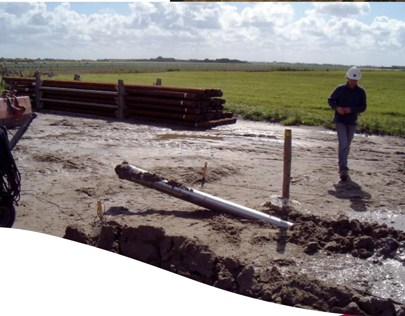
Einde HDD-boring
